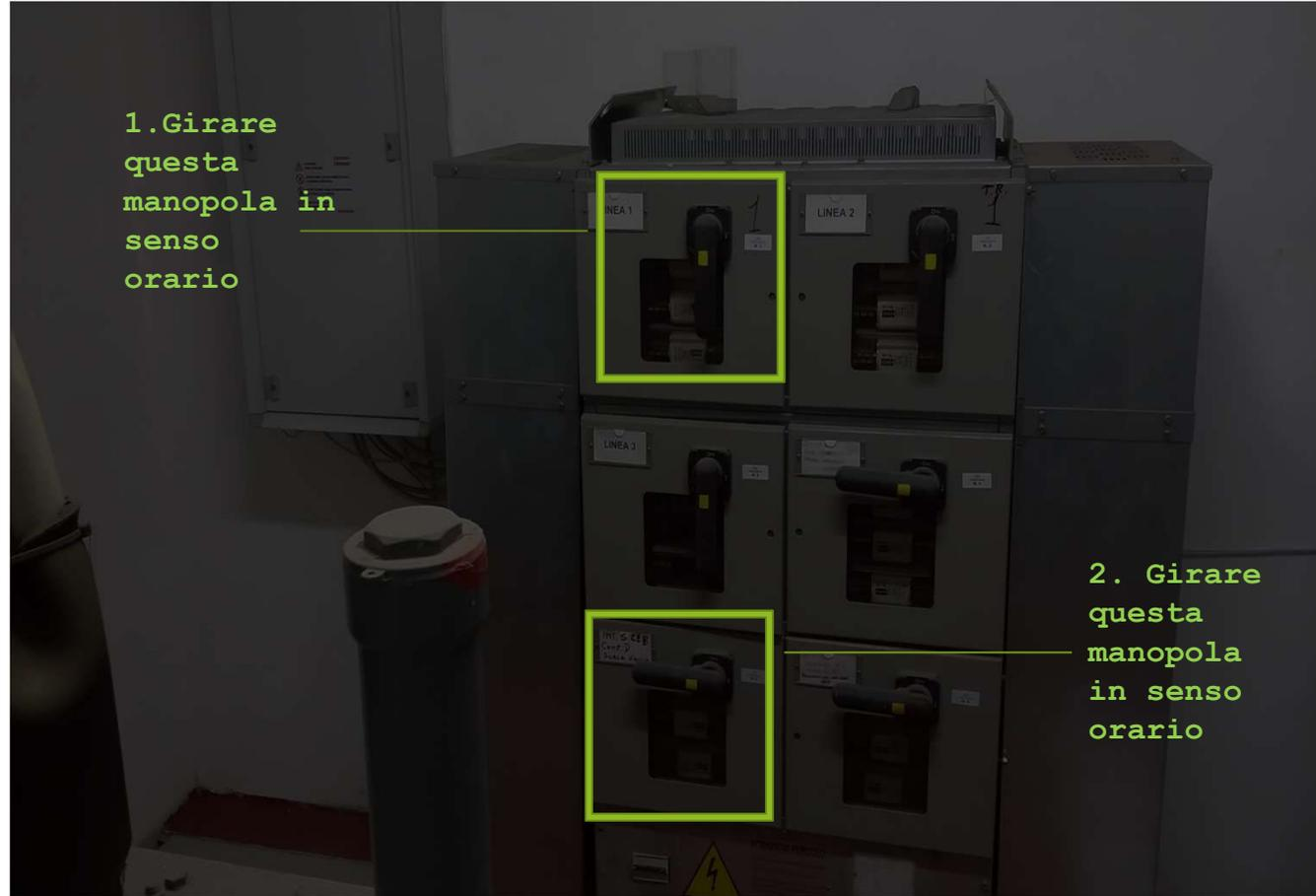
Tramite applicazione in Realtà Aumentata, vengono illustrate le procedure di messa in esercizio di un determinato apparato
