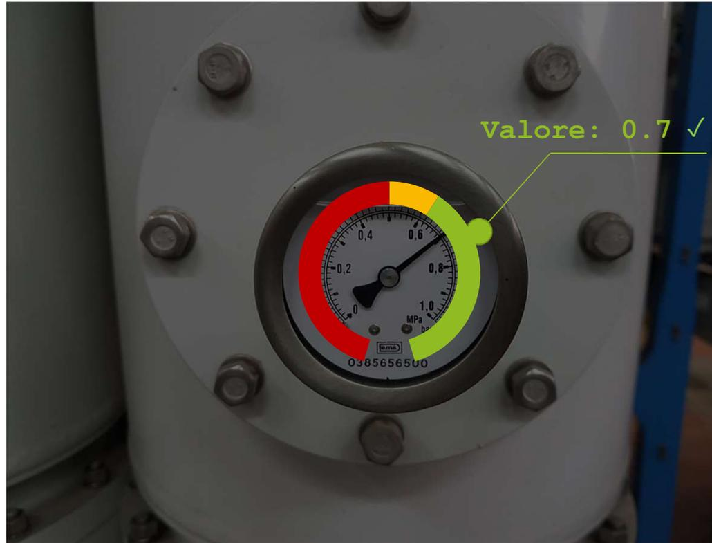
Tramite algoritmo OCR viene estratto il dato analogico del manometro e convertito in digitale.
